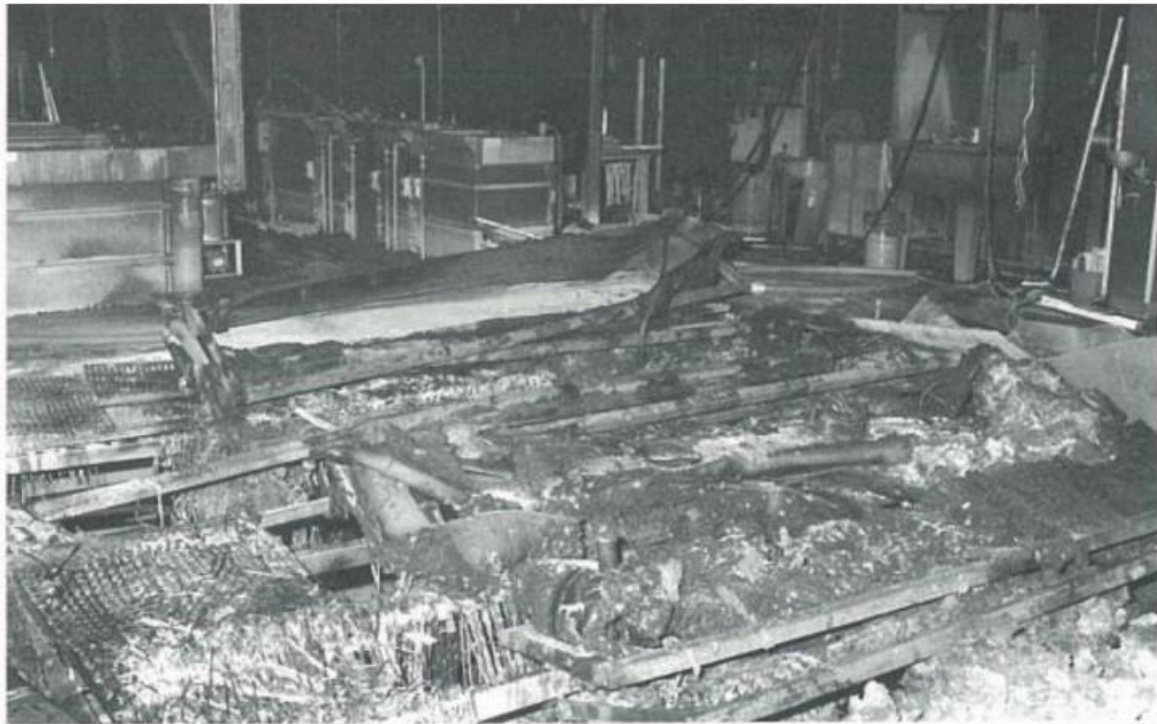
"Het beitsgedeelte van de galvanische ruimte platgebrand". Foto uit MEOBTIEK.
